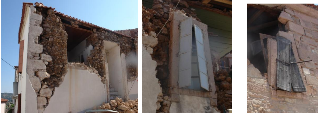
Ασύνδετοι λαξευτοί γωνιόλιθοι και λαξευτά περιθυρώματα (σουβελίκια)
