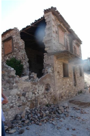
Η κατασκευή καμινάδων με οπτόπλινθους αποτελεί ασυνέχεια στην λιθοδομή
