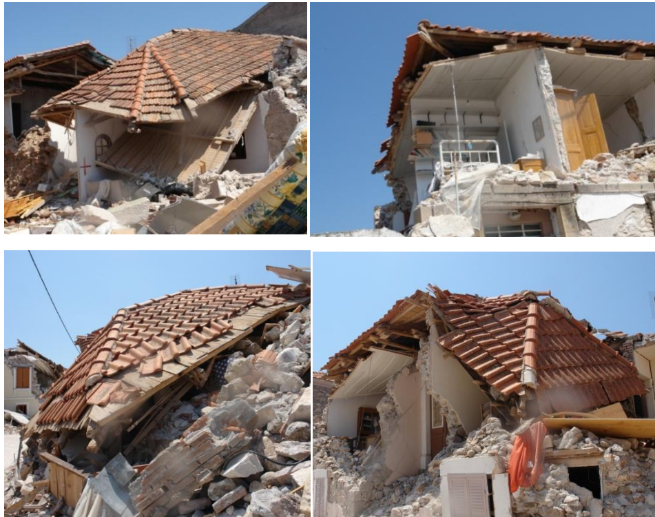
Κατάρρευση στεγών χωρίς στρωτήρες, ασύνδετων με την λιθοδομή,
