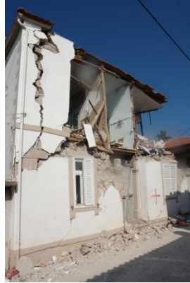
Στέγες και πατώματα ασύνδετα με την τοιχοποιία
