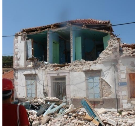
Βλάβες από ανατροπή -κατάρρευση εξωστών οπλισμένο σκυρόδεμα
