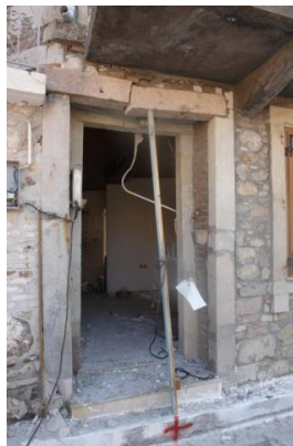
Βλάβες οφειλόμενες σε προσθήκη εξωστών από οπλισμένο σκυρόδεμα
