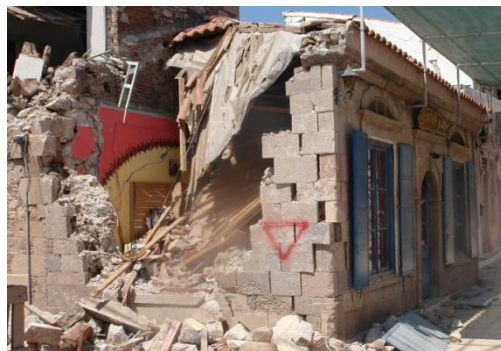
Κατασκευή λιθοδομών και Βλάβες
