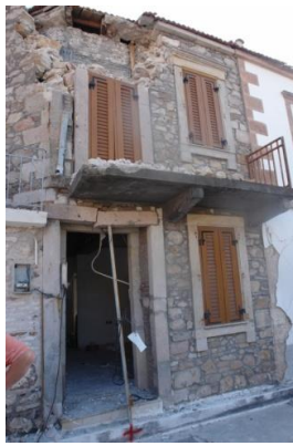
Βλάβες οφειλόμενες σε προσθήκη εξωστών από οπλισμένο σκυρόδεμα
