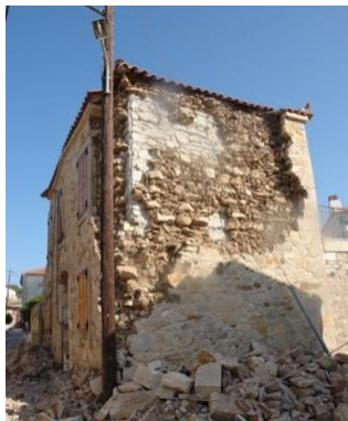
Επισκευή προγενέστερης βλάβης με οπλισμένο επίχρισμα
