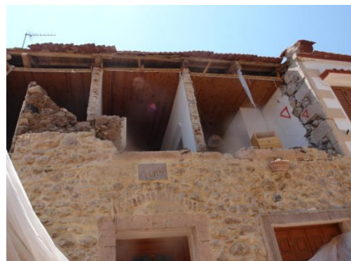
Λιθοδομή ασύνδετη με ξυλόπηκτους τοίχους . Έλλειψη περιμετρικού εξωτερικού τοίχου
