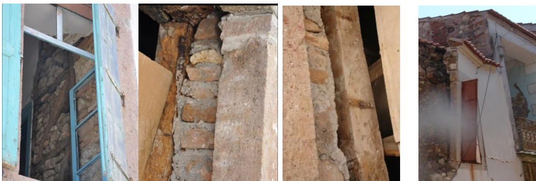
Έλλειψη συνδέσμων μεταξύ λαξευτών πλαισίων ανοιγμάτων και ξύλινου αντισεισμικού συστήματος
