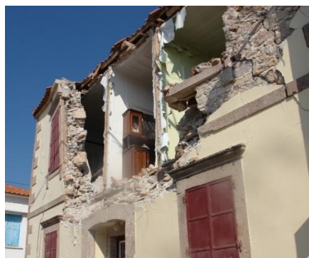
Λιθοδομή ασύνδετη με ξυλόπηκτους τοίχους . Έλλειψη περιμετρικού εξωτερικού τοίχου
