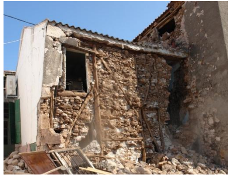
Ανατροπή εξωτερικής τοιχοποιίας- έλλειψη σύνδεσης με το αντισεισμικό σύστημα εσωτερικής παρειάς
