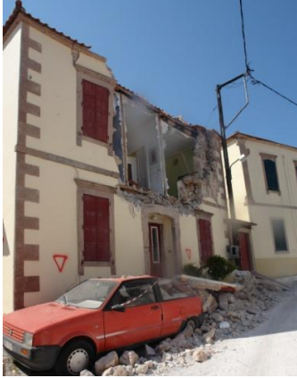
Βλάβες από ανατροπή -κατάρρευση εξωστών οπλισμένο σκυρόδεμα
