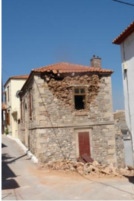
Στέγες και πατώματα ασύνδετα με την τοιχοποιία
