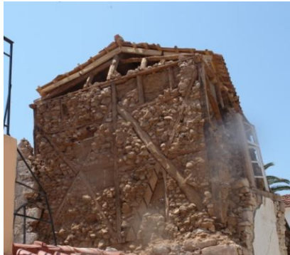
Ανατροπή εξωτερικής τοιχοποιίας- έλλειψη σύνδεσης με το αντισεισμικό σύστημα εσωτερικής παρειάς
